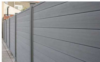
Plné oplocení (neprůhledné), vytvořené z desek pero-drážka DF1B15
