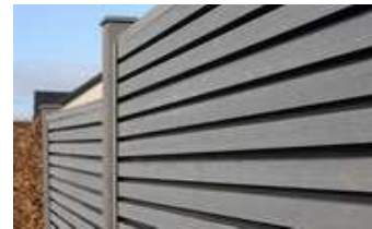
Lamelové oplocení (neprůhledné), vytvořené z desek pero-drážka DF4B20
